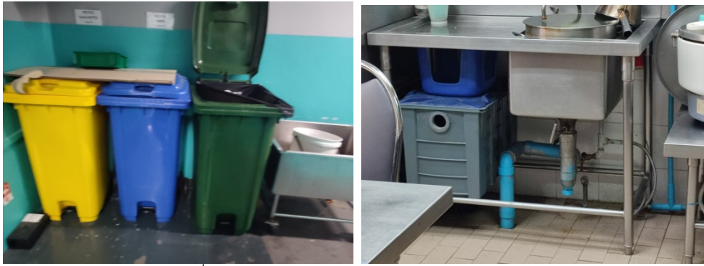
ภาพที่ 4-10 ถังรองรับมูลฝอยขนาด 100 ลิตร และถังดักไขมัน
