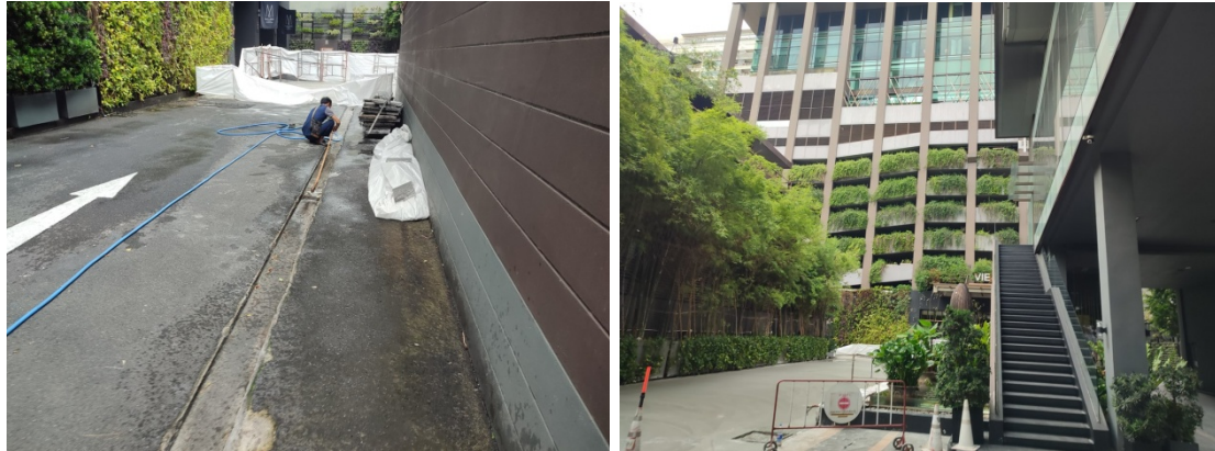
ภาพที่ 4-40 กันขอบเขตห้ามเข้าช่วงที่กำลังก่อสร้างซ่อมแซมพื้นผิวถนนให้กลับมามีสภาพที่ดี
